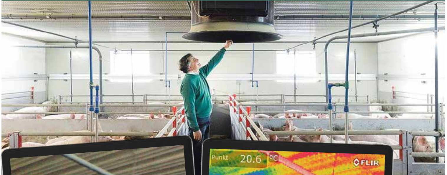
Beim Stallklima-Check (unten) lassen sich Problemstellen rasch finden. In diesem Fall führt die fehlende Pressung der Dämmlage zur Falschluff. STIEFKIND, SBS
